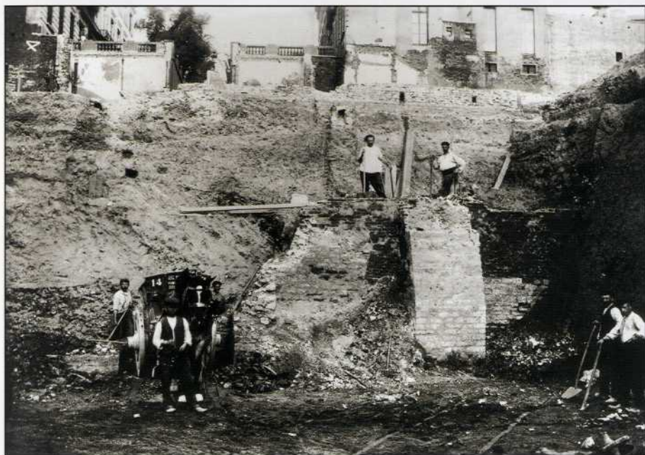
Vue du mur, rue Baron Horta, (ca 1911), (©IRPA-KIK, Bruxelles).
