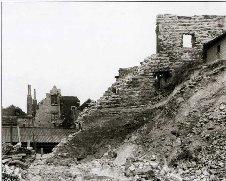
Mur d'enceinte situé à l'emplacement de la Bibliothèque royale Albert Ier (1953), (©IRPA-KIK, Bruxelles).
